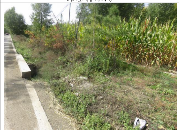
K13+960 涵洞施工便道绿化
