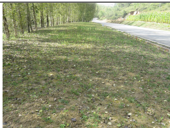
施工便道恢复后
