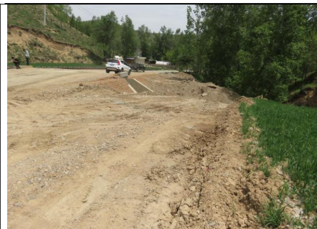
施工便道恢复前
