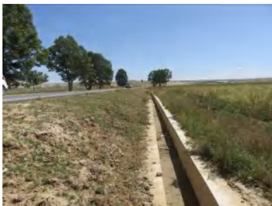
K145+200 路基工程区边坡种草
