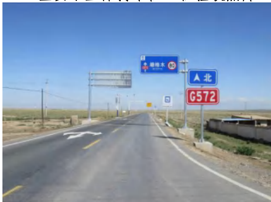
G572 线塘切改建公路 K133+925 起点
