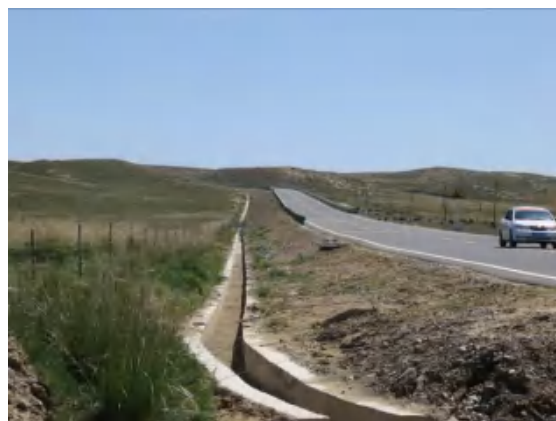
路基工程区排水沟
