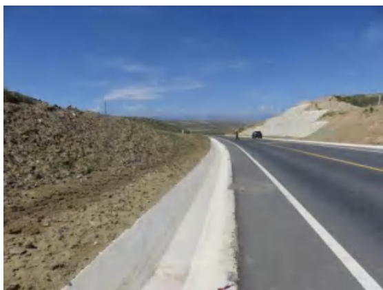
路基工程区排水沟
