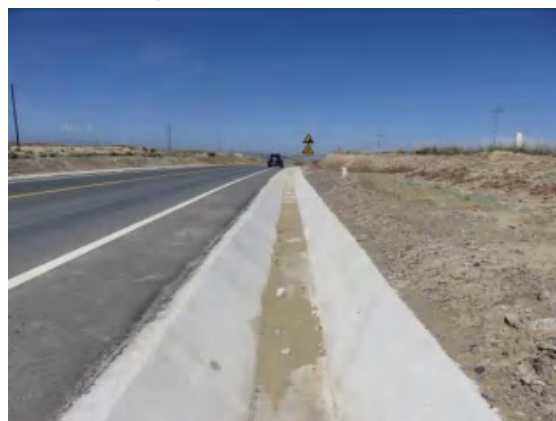
路基工程区排水沟
