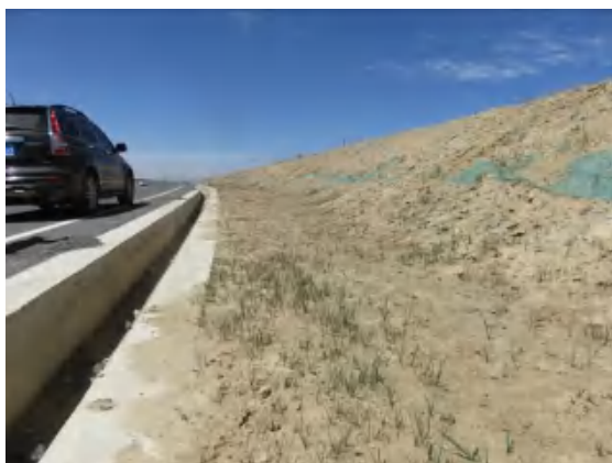
K164+900 路基工程区边坡种草
