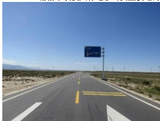
G572 线塘切改建公路 K190+660 终点
