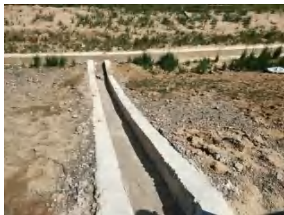
路基工程区急流槽
