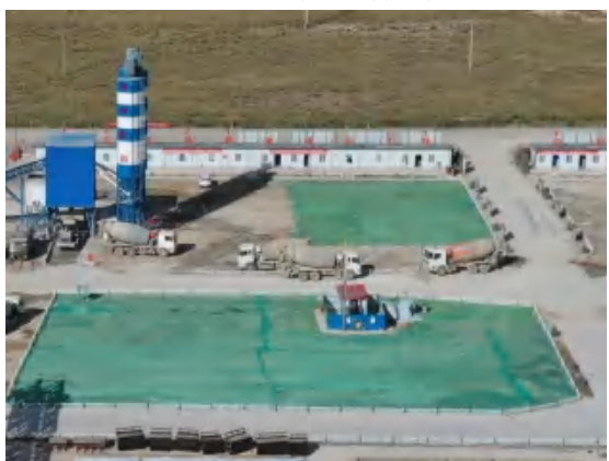
密目网临时苫盖
