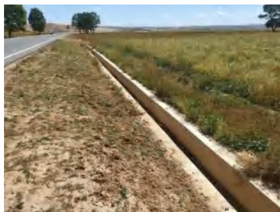
路基工程区边坡种草
