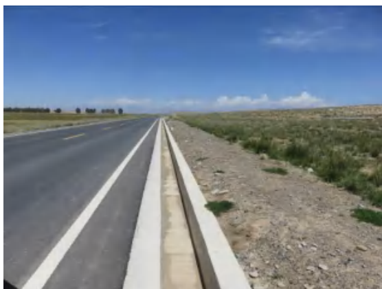
K146+060 路基边坡排水边沟
