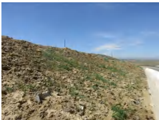
路基工程区边坡种草
