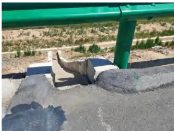
路基工程区急流槽
