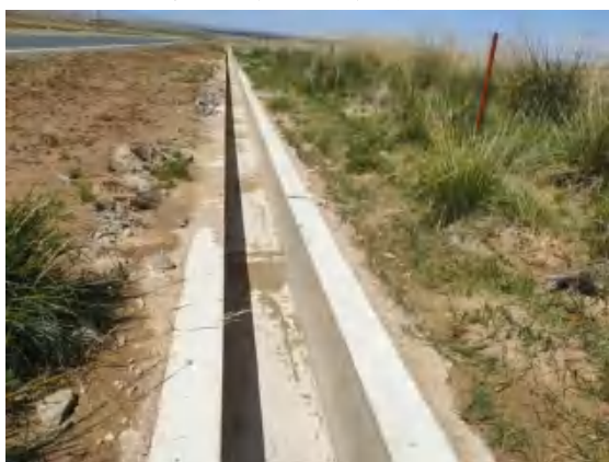
路基工程区排水沟
