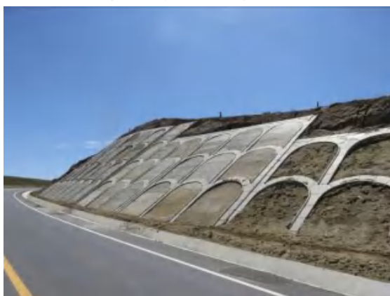
路基工程区骨架护坡
