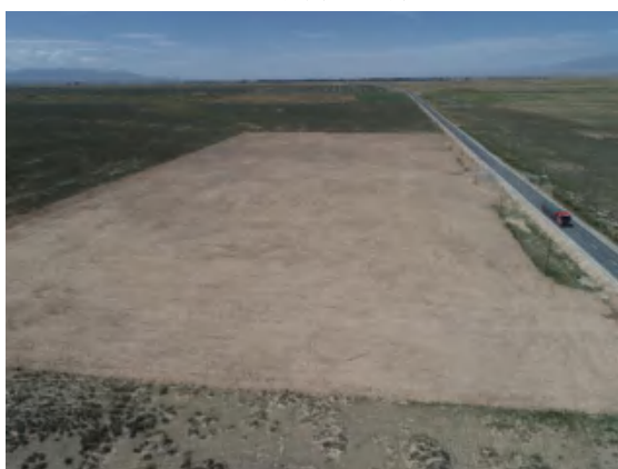
K165+300 施工生产生活区恢复
