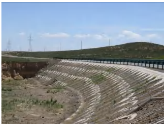
K156+300 路基工程区骨架护坡
