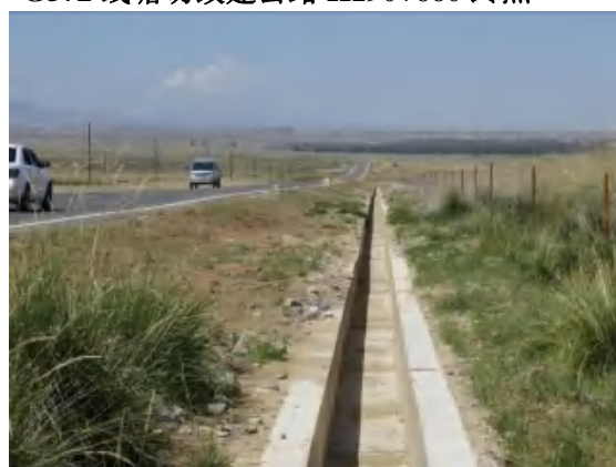
路基工程区排水边沟
