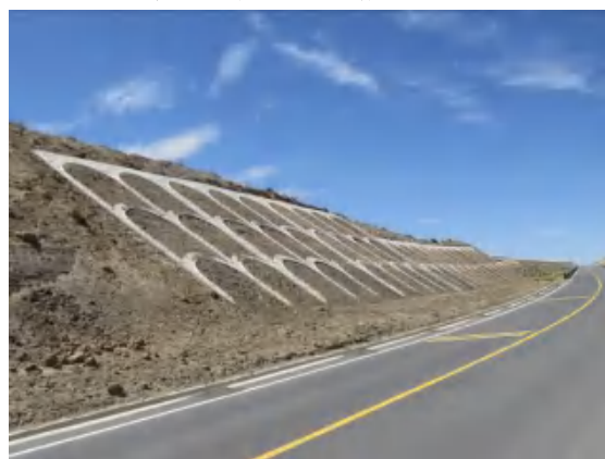
路基工程区骨架护坡
