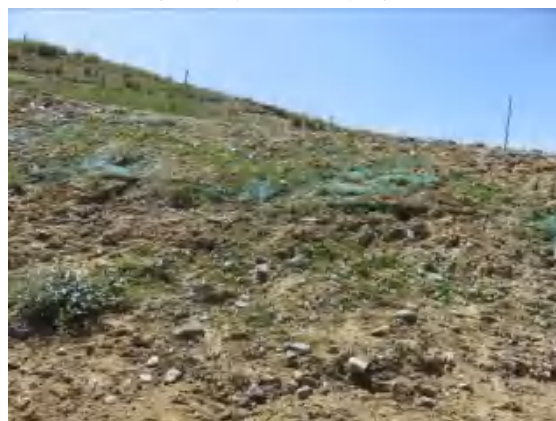
路基工程区边坡种草
