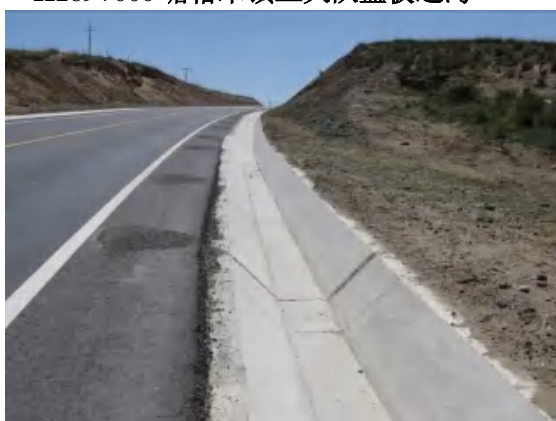
路基工程区排水沟
