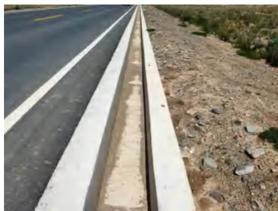
路基工程区排水沟
