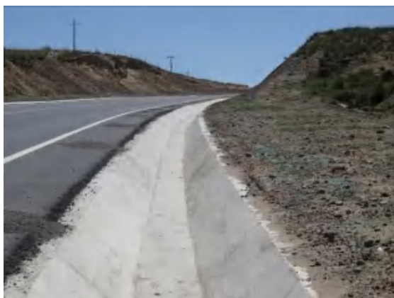
路基工程区排水沟
