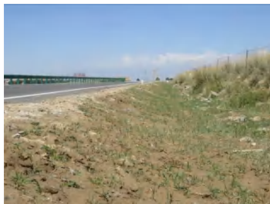
K146+500 路基工程区边坡种草
