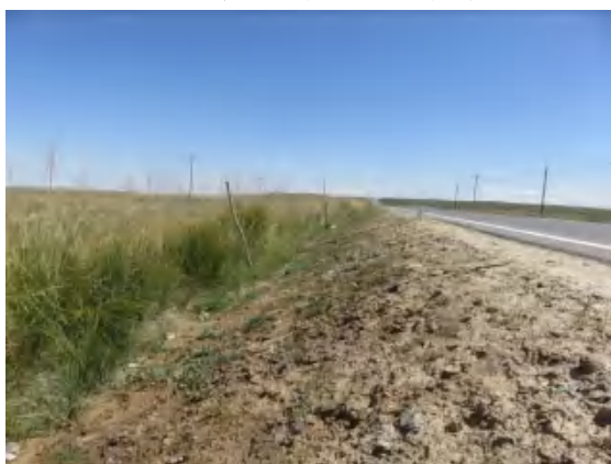
K165+700 路基工程区边坡种草
