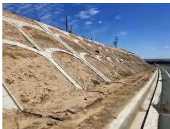
路基工程区骨架护坡
