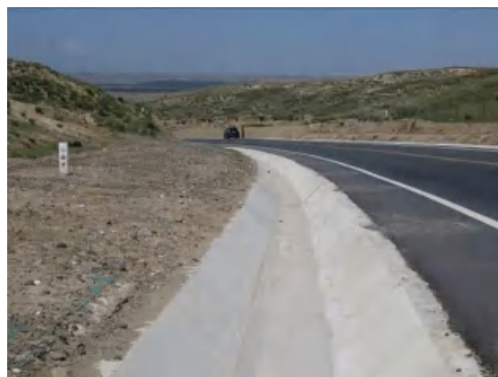
路基工程区排水沟
