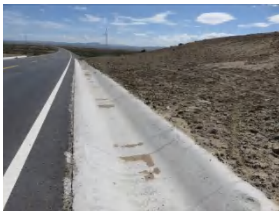
路基工程区排水沟
