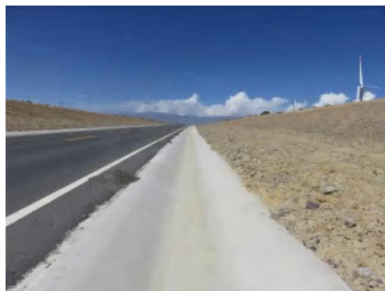
路基工程区排水沟
