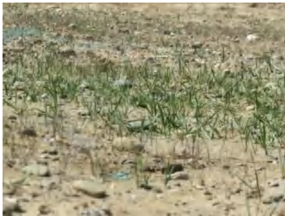
路基工程区边坡种草
