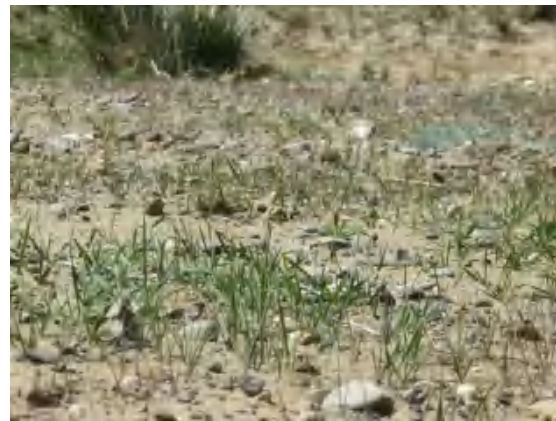
路基工程区边坡种草
