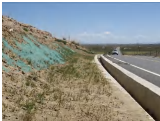
K164+900 路基工程区边坡种草
