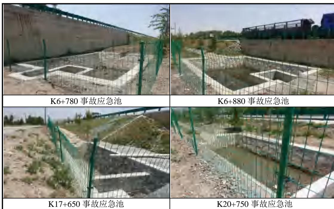
图 6.3-1 桥梁径流收集系统照片
