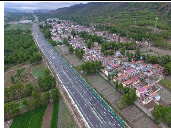
高羌村段框格植物综合护坡
